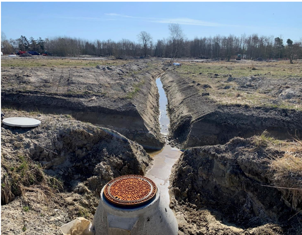
I den nye sommerhusudstyknig ved Sillestrup Øvej indgår nygravede grøfter som en naturlig del af afvandingen fra området. Måske vil vi se noget lignende i Marielyst Grundejerforenings område. (Foto: Flemming J. Mikkelsen)
